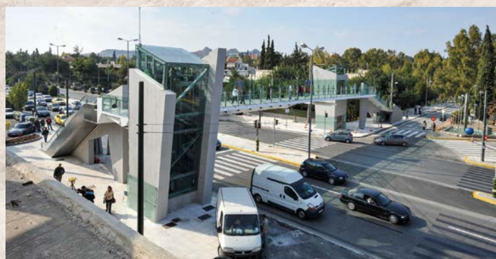
Δεκέμβριος 2009: Ανάληψη πρωτοβουλίας για την κατασκευή Γέφυρας Πεζών στη Λεωφόρο Κηφισίας
