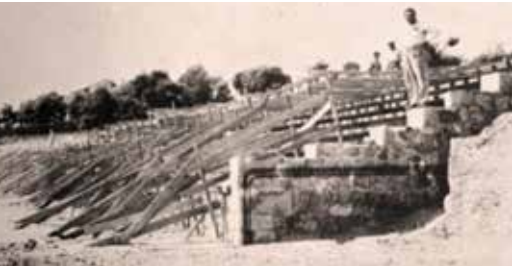
Η κατασκευή του Σταδίου Στεφάνου Δέλτα
