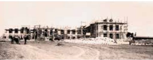
Το Μπενάκειο υπό κατασκευή το 1928
