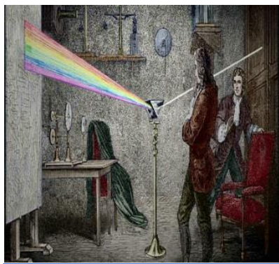
Ο Νεύτωνας τοποθετεί το γυάλινο πρίσμα στην πορεία του λευκού φωτός με αποτέλεσμα να φανεί το φάσμα του.
