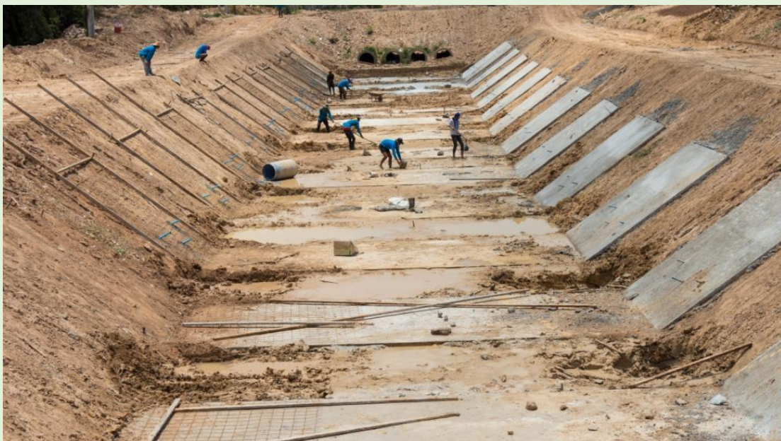
Εικόνα 4. Αντιπλημμυρικά έργα για τη διευθέτηση του ρέματος Εσχατιάς
