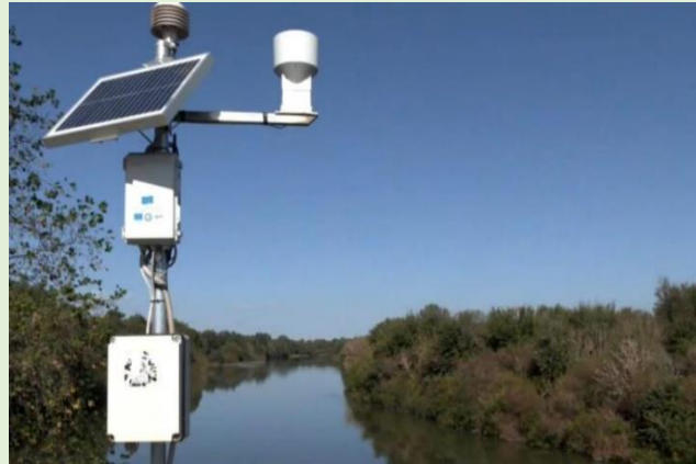
Εικόνα 2. καινοτόμο σύστημα παρακολούθησης υδάτων στον Αξιό Ποταμό
