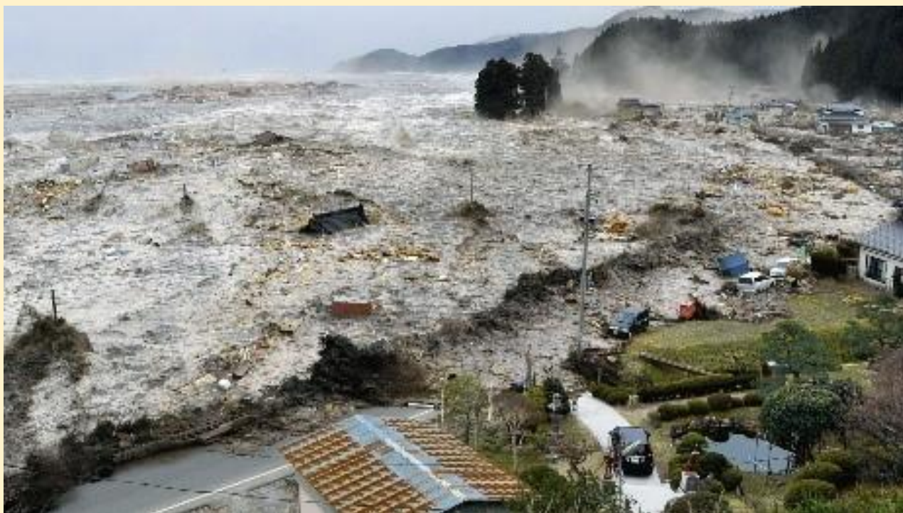
Εικόνα 11 Η καταστροφή της Rikuzentakata
