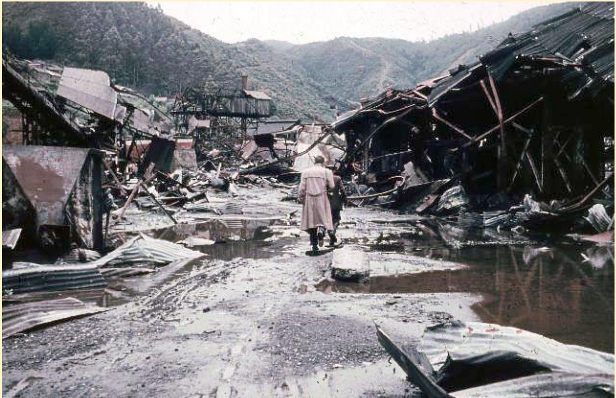
Εικόνα 4 Κατεστραμμένη περιοχή από τον σεισμό της Χιλής το 1960
