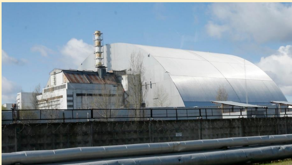
Εικόνα 6 Κέλυφος προστασίας του πυρηνικού σταθμού στο Τσερνόμπιλ
