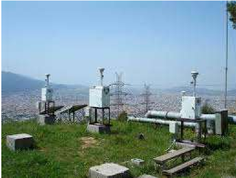
Εγκαταστάσεις ΙΕΠΒΑ στο λόφο της Πεντέλης.
